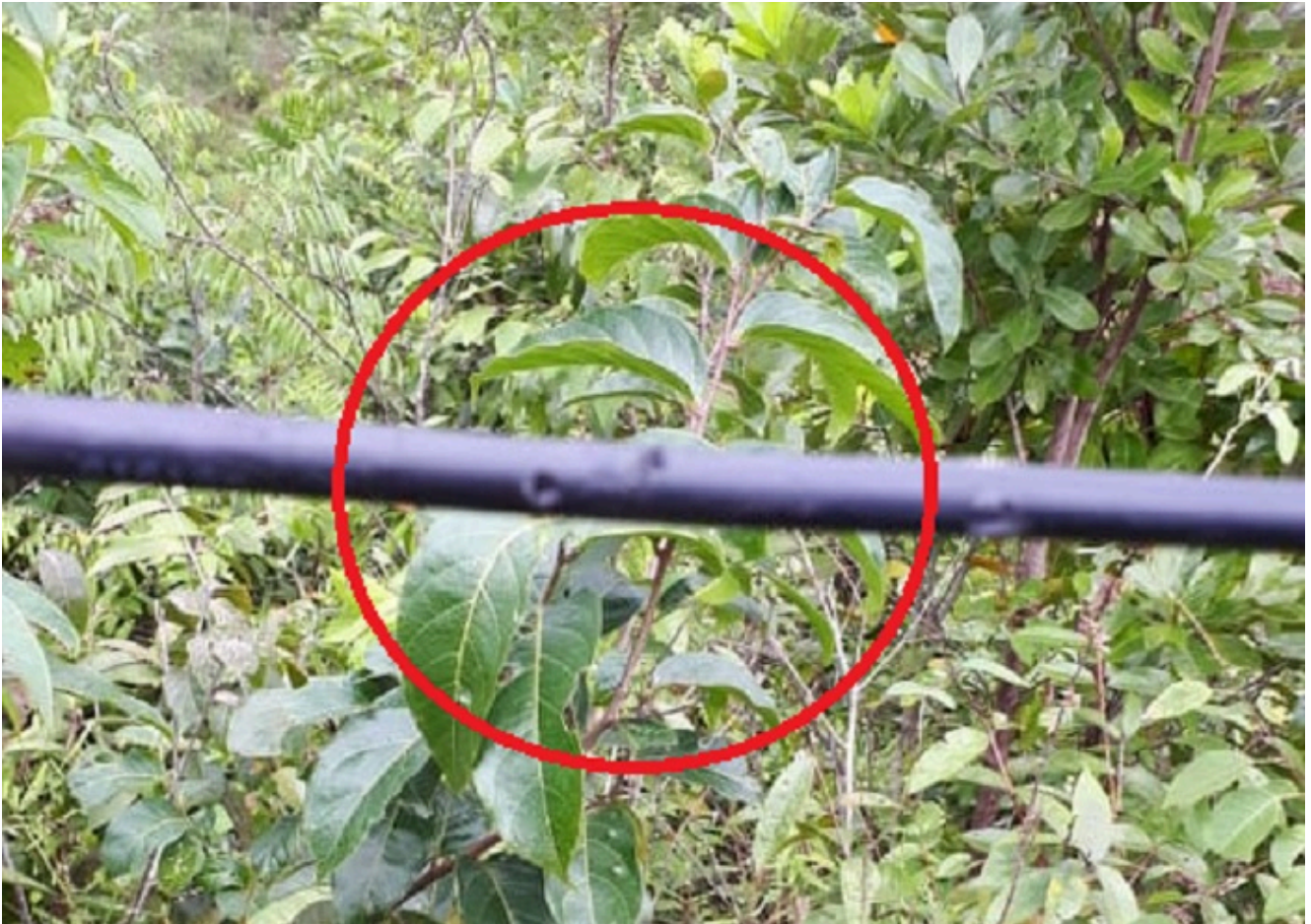
Cabo fibra ótica furado na sabotagem (Foto:Divulgação WSP)
